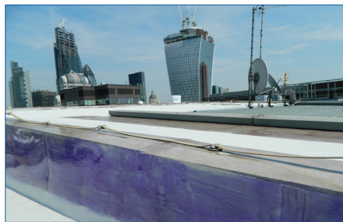
Surface conditionnée pour assurer une bonne adhésion
