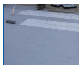
La protection de la toiture avec Belzona
