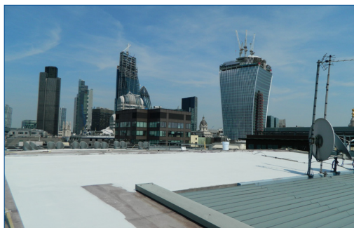
1ère couche de Belzona 3111 appliquée
