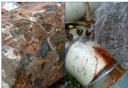
Fig 1 : Érosion, corrosion et dommages par piqures.
