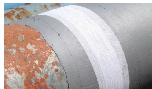
Belzona 1831 (Super UW-Metal) Remplissage final et enveloppe
