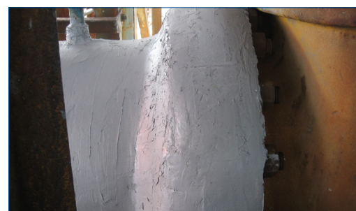
Belzona 1831 (Super UV-Metal) scellage de bride
