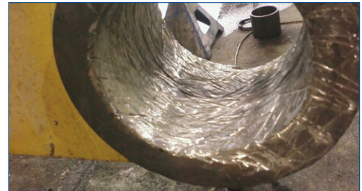
Préparation de la surface terminée
