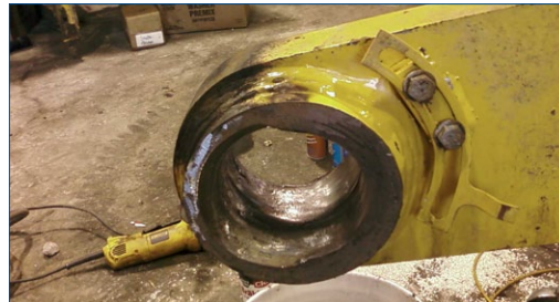
Logement de bague endommagé
