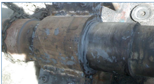
Belzona appliqué, moule en place
