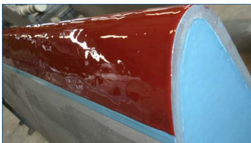
Application de Belzona 2121
