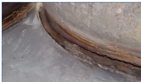
Joint endommagé sur une unité de CVC
