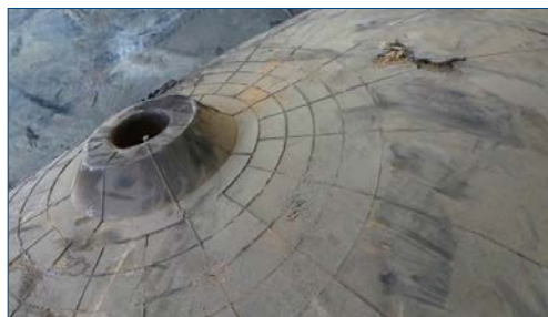
Défense d'accostage en caoutchouc endommagée
