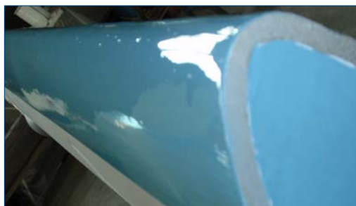
Application de Belzona 1341
