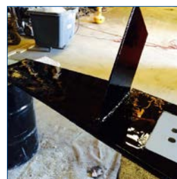
Protection d'une pale d'agitateur
