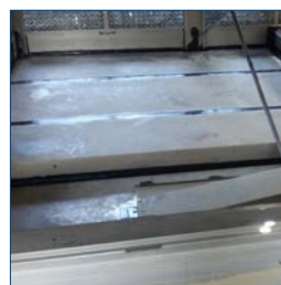
Étanchéification des joints d'une tour de refroidissement
