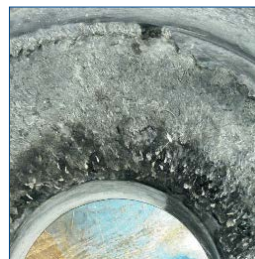
Revêtement en caoutchouc endommagé sur un carter de pompe
