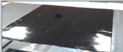
6. Application de la couche de finition
