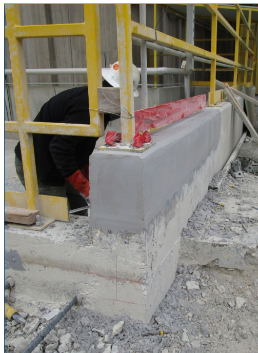
Mur de confinement secondaire reconstruit et finalisé avec une couche de Belzona 4111
