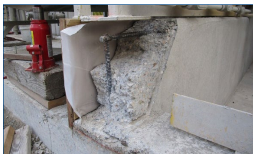
Élimination de tout le béton détérioré
