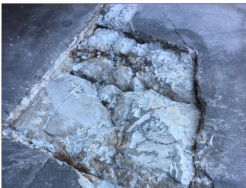
Les chocs occasionnés par la circulation intense endommagent le béton
