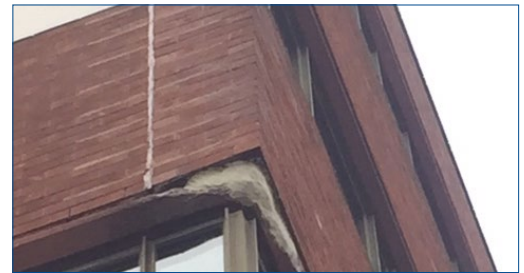
Linteaux en surplomb détériorés
