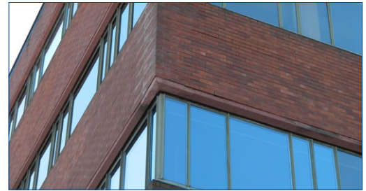
Zone en surplomb reconstruite avec des matériaux légers
