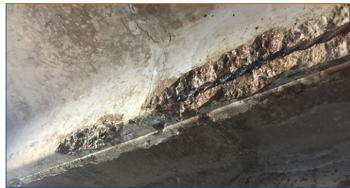
Béton de plafond détérioré dans un parc de stationnement
