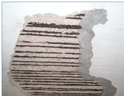
La corrosion du métal cause l'effritement du béton
