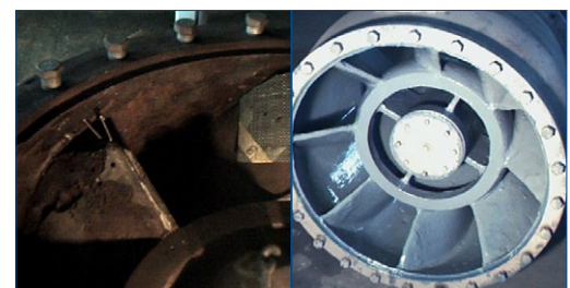
Palettes de diffuseur avec Application terminée une toile en acier installée
