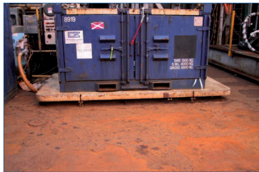
Plate-forme corrodée
