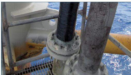
Quatre bandes de Belzona 1982 appliquées
