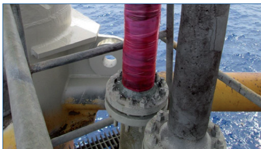
Belzona 9382 pour consolider la réparation
