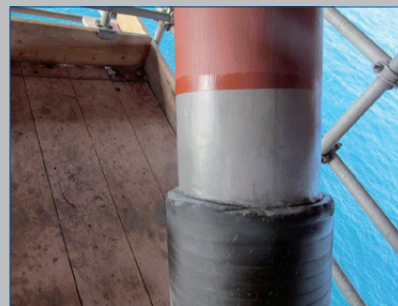
Quatre bandes de Belzona 1982 appliquées
