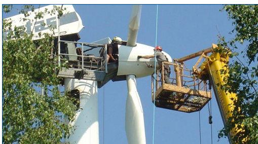
Réparation à l'intérieur de la nacelle avec Belzona 1131 (Bearing Metal) Vol. XXXII, n° 48
