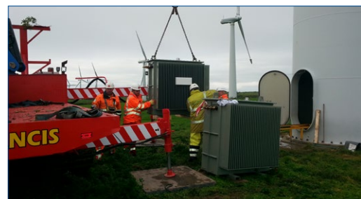
Réparation d'un transformateur avec Belzona 1212 Vol. XXXII, n° 18
