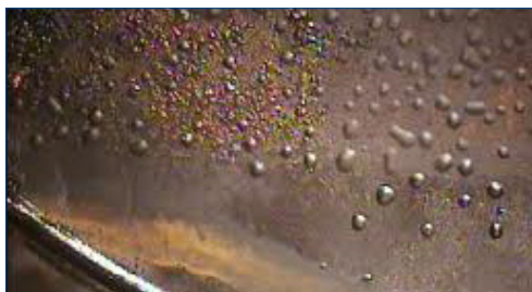
Cloques sur revêtement à faible densité de réticulation
