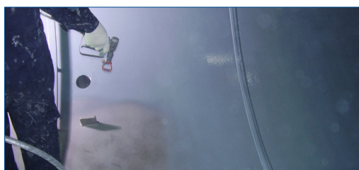
Revêtement appliqué par pulvérisation
