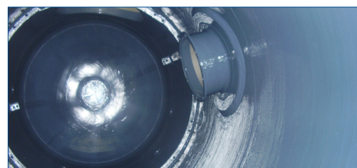
Cuve de process protégée contre la corrosion
