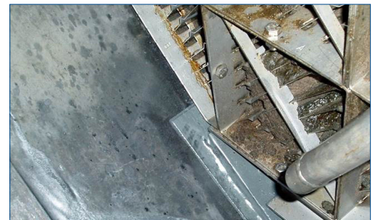
Inspection 8 ans plus tard
