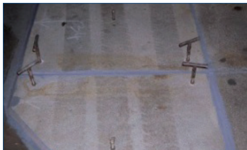
Collage de plaque sur le pont
