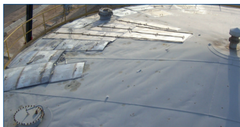
Collage de plaque Belzona
