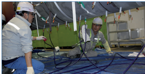
Injection de Belzona 1321
