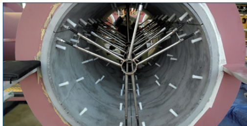
Installation de paliers
