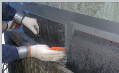
Réparation de base de réservoir
