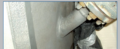
Buse corrodée
