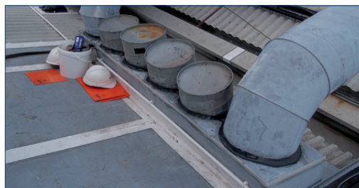
Tous les joints scellés avec Belzona 2211
