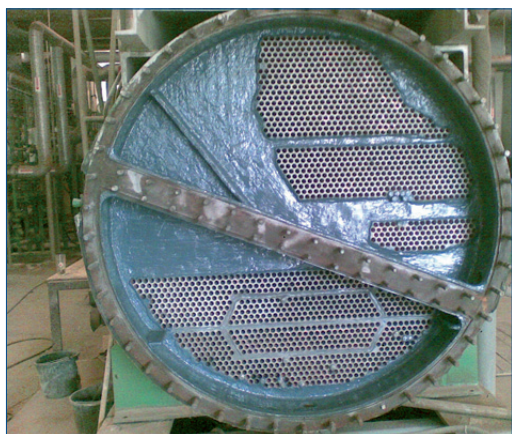
Revêtement de la plaque tubulaire
