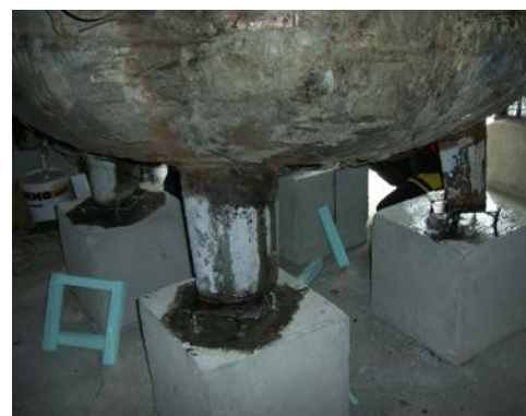
Préparation et conditionnement de la surface
