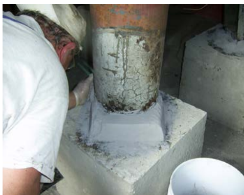
Application de Belzona en action
