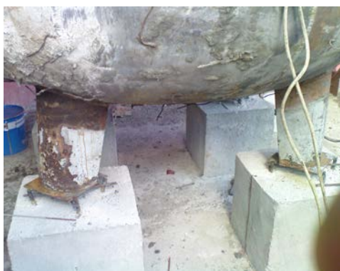
Détérioration des supports de la cuve
