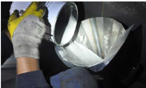
Coulage de Belzona 7111
