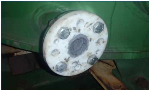
Moule mis en place avec du matériel Belzona
