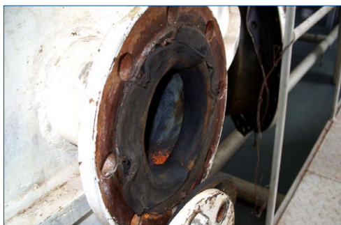
Face de bride très corrodée
