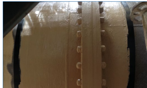
1ère couche de Belzona 3411 appliquée
