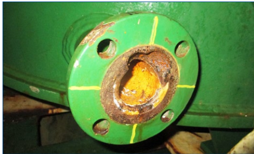
Face de bride très corrodée
