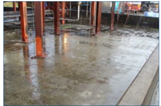
Zone de confinement avant l'application
