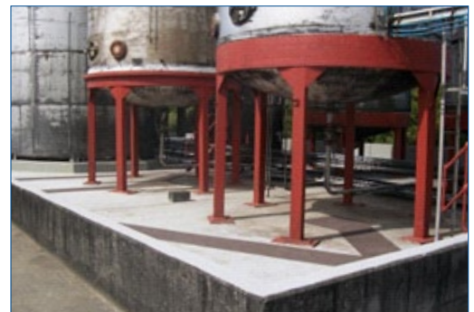
Réparations de la surface en béton
