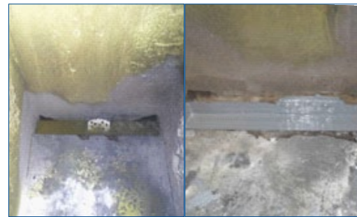
Dommages sur le réservoir contenant de l'acide chlorhydrique à 36% réparés
