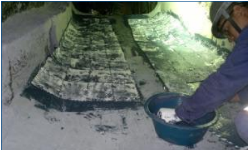
Belzona 9811 appliqué sur le caniveau
