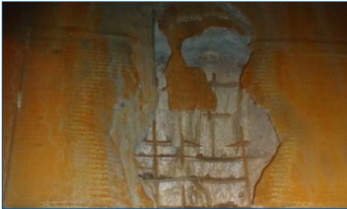
Les zones endommagées du puits en béton
