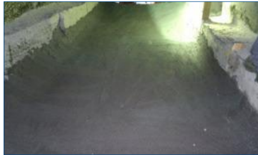
Application complétée sur le caniveau
