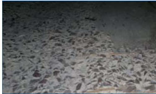
Caniveau en béton armé
