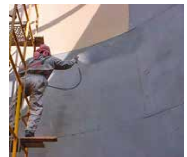
Revêtement des réservoirs
