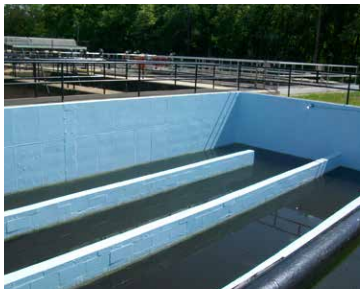
Belzona 5111 utilisé pour la protection des parois d'un réservoir de chlore
