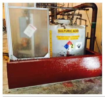
Belzona 4361 est un revêtement souple de type barrière destiné à la protection des zones de confinement chimique.
