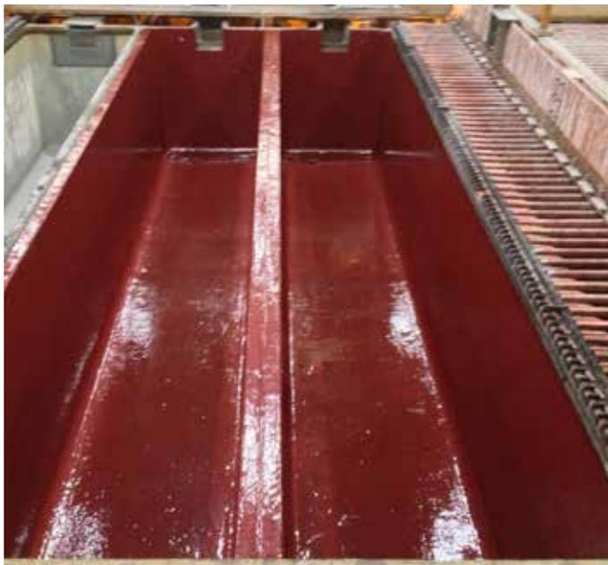
Belzona 4341 (Magma CR4) est un revêtement bi-composants de type barrière destiné à la protection des surfaces soumises à des attaques chimiques. Il est optimisé pour la résistance aux acides inorganiques tels que l'acide sulfurique et l'acide chlorhydrique, jusqu'à 90 °C (194 °F) en immersion.
