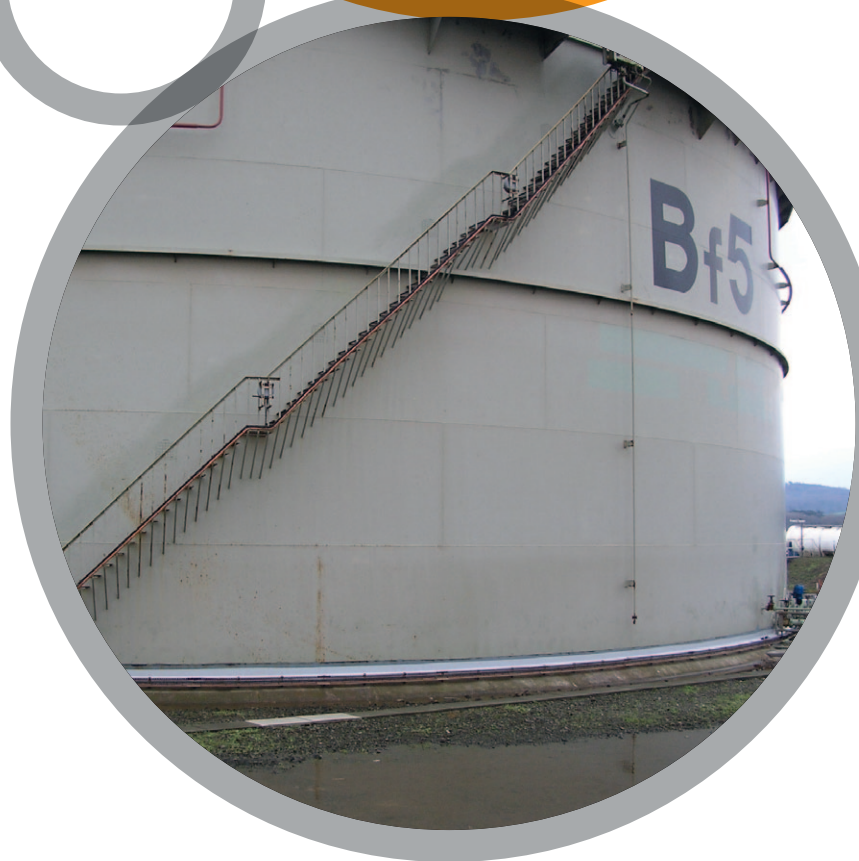
Réservoirs de stockage de produits chimiques
