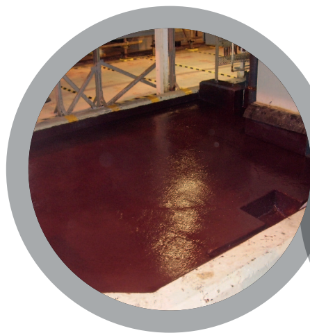
Cuves de rétention de produits chimiques
