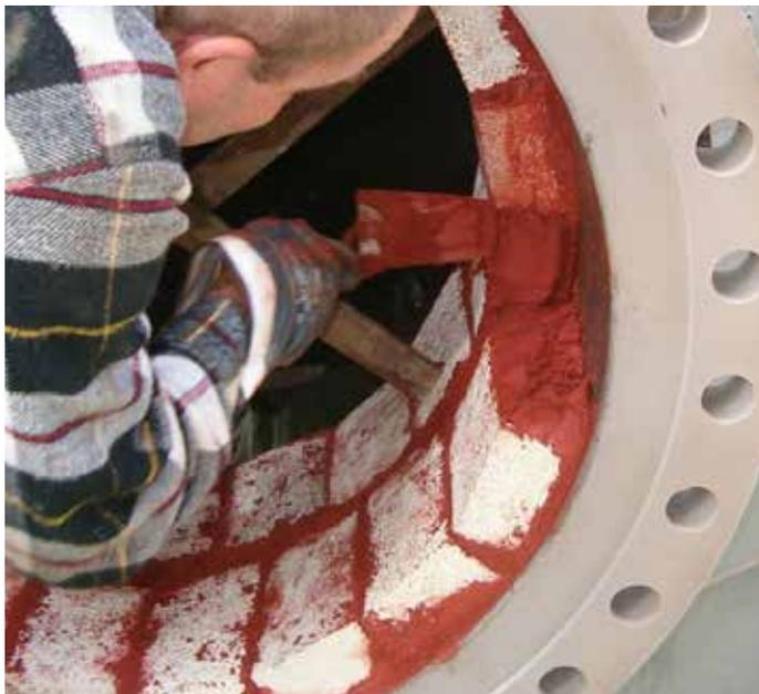
Belzona 4181 (AHR Magma-Quartz) est un système résistant aux acides et à la chaleur pour la réparation et la protection du béton, de la pierre et d'autres substrats rigides soumis à des chocs, à de l'abrasion ou à des attaques chimiques.
