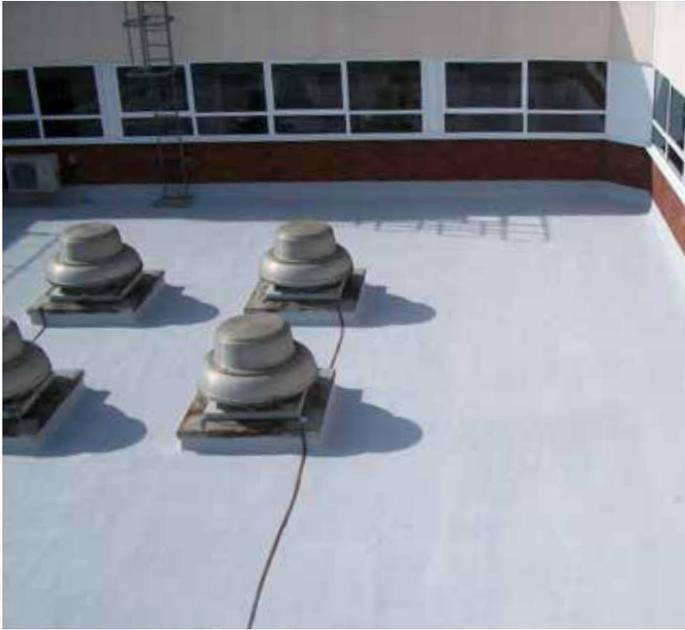
Belzona 3111 (Flexible Membrane) est un revêtement microporeux mono-composant sans solvant pour la réparation et la protection à long terme de tous types de toits, de bases de réservoirs et d'autres structures.
