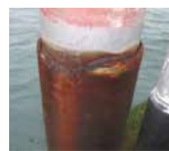
Matériaux différents liés par un joint étanche
