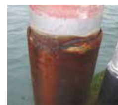
Matériaux différents liés par un joint étanche
