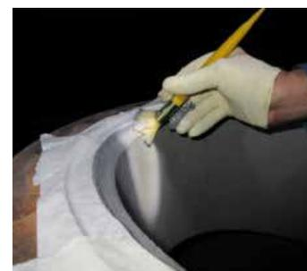
Cuve à haute température gravement touchée par la corrosion. Surface chancrée reconstituée avec Belzona 1511.
