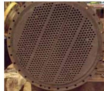
Face d'un tube d'échangeur thermique endommagée par de la corrosion galvanique et par piqûres. Reconstituée avec Belzona 1511 avant application d'un revêtement Belzona haute température.
