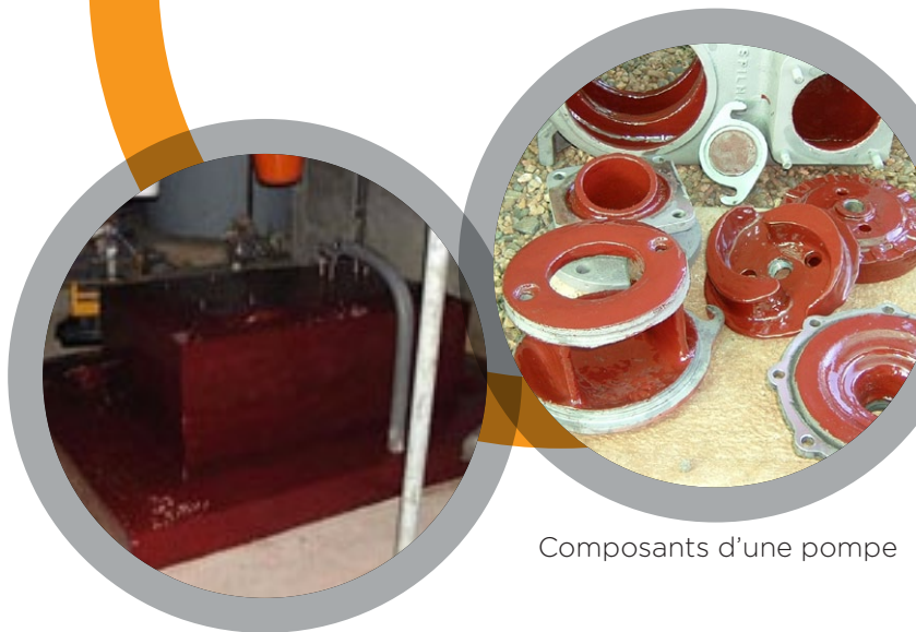
Plinthes d'une pompe
